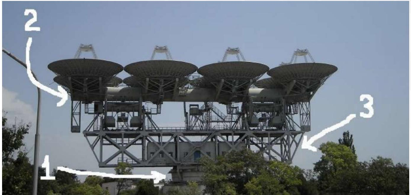
1. Поворотный механизм орудия с тяжёлого боевого корабля.
